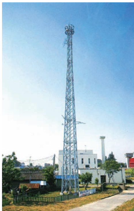
(国) 下館工事事務所 真岡出張所 (KU41形 高さ41m)
