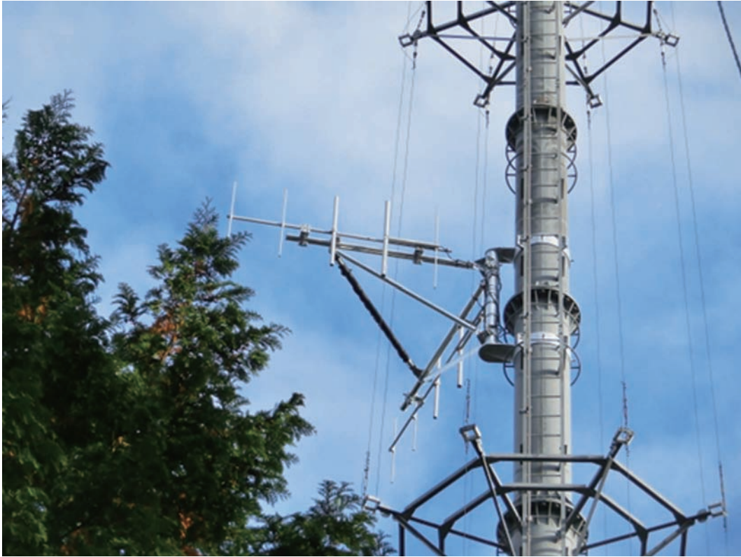
FM補完用5素子八木アンテナ（南海放送、大洲局 FM 補完局 30W）
